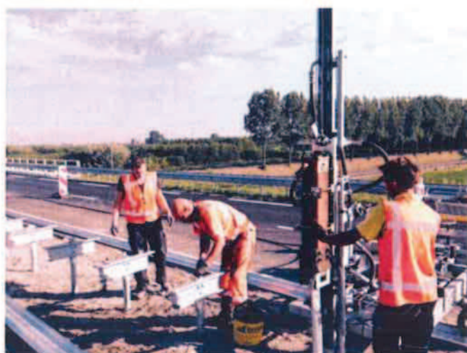
Hei-installatie die een paal de grond in slaat.
