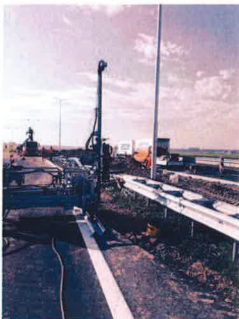
Hei-installatie geplaatst op de geleidrail
